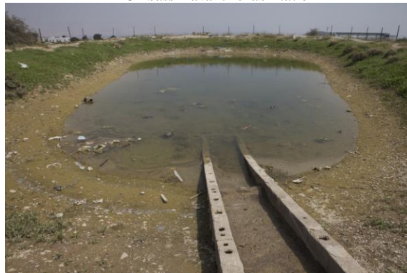
Un bassin avant réhabilitation
